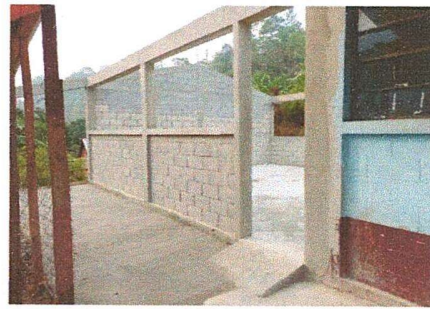
Foto 4: EN PROCESO DE TRABAJO
