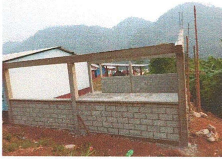
Foto 1: REABILITACION DE AULA
