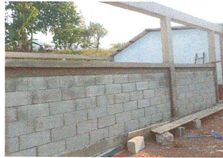
Foto 2: EN PROCESO DE TRABAJO
