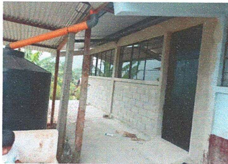
Foto 5: REABILITACION DE TECHO DE AULA
